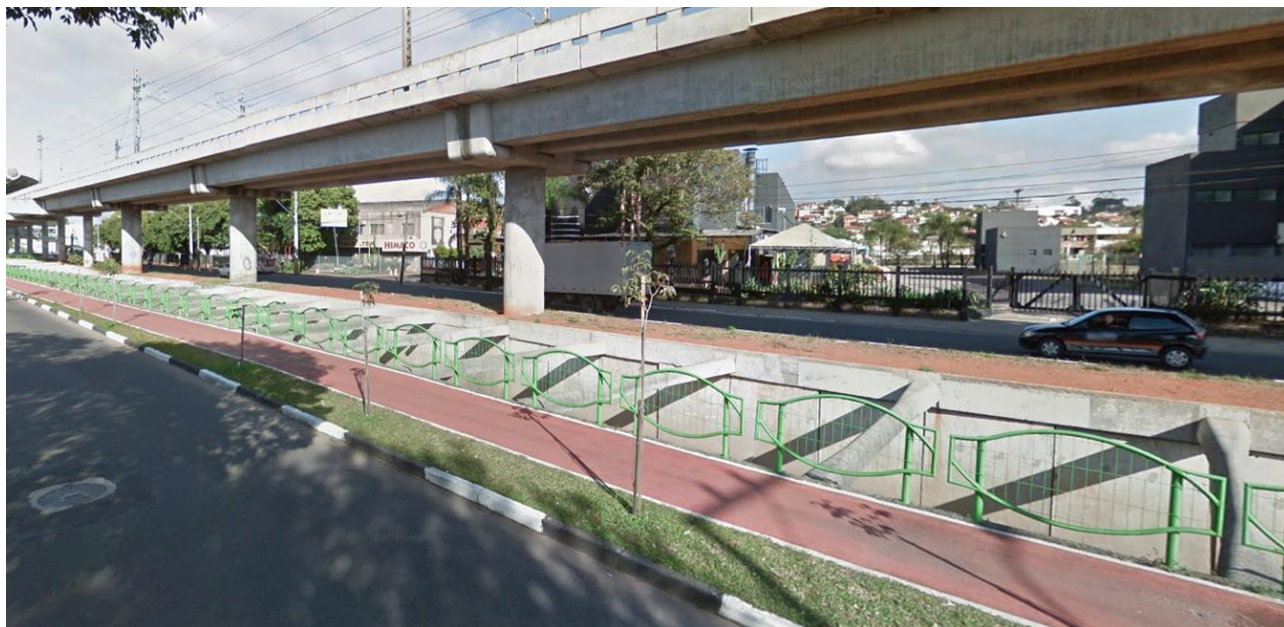
Ciclovia na avenida Nações Unidas, a única infraestrutura ciclista na cidade de Novo Hamburgo
