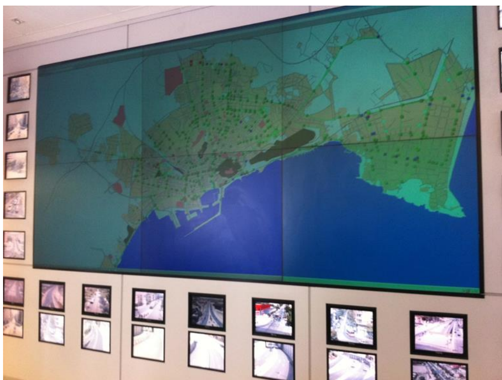
Imagem 104 Centro de Controle do tráfego de Alicante. Espanha
