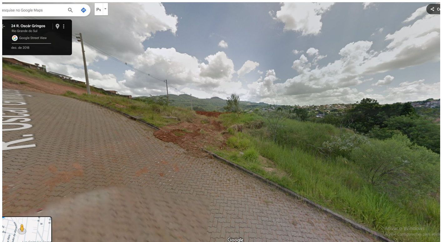
Acesso ao condomínio 4, pela Rua Oscar Grings
