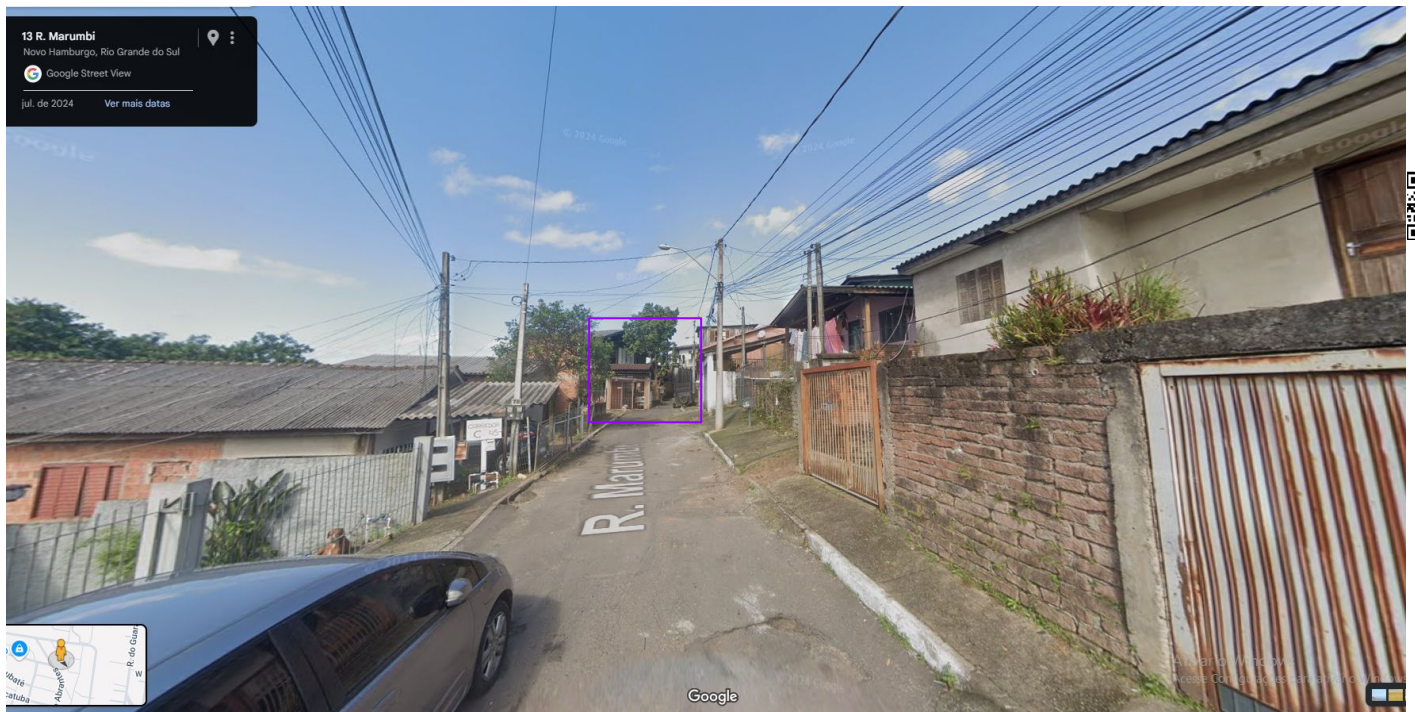
Final Rua Marumbi, edificação sobre a Rua
