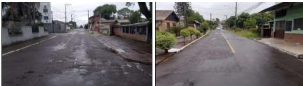
FOTO 9: Intersecção 1 – Vista para a Rua Saldanha da Gama, sentido sul (Rua Osvaldo Cruz).
