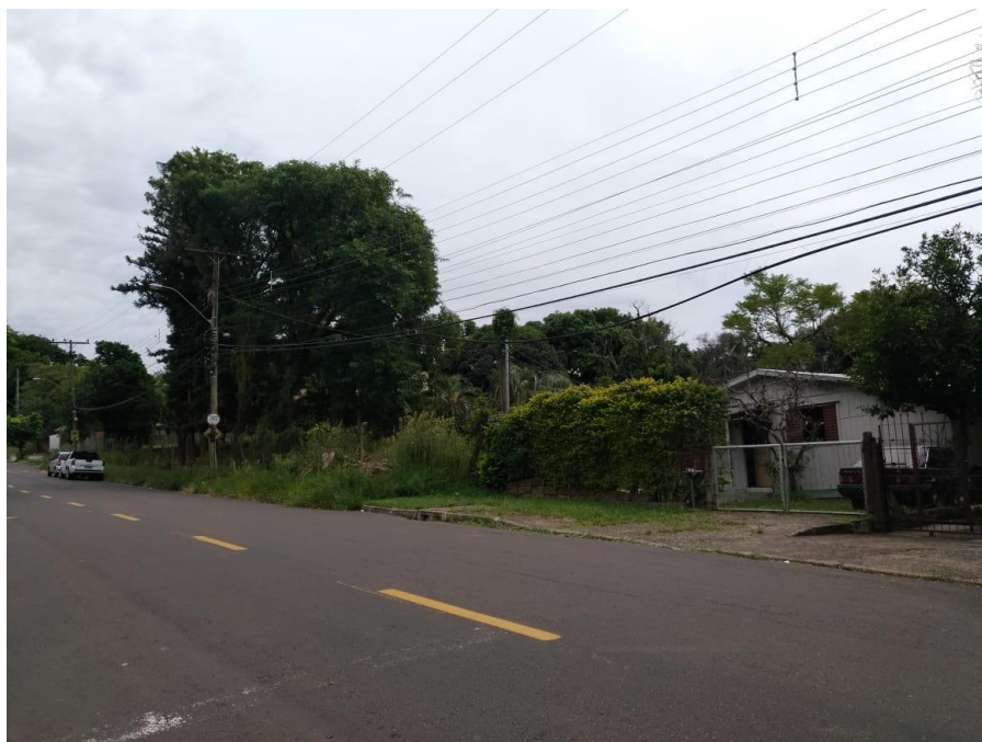
Figura 5 – Vista da gleba junto a Rua Coronel Jacob Kroeff Filho.
