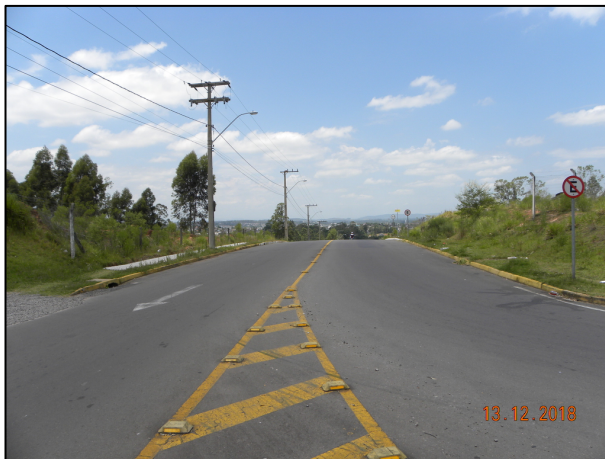
FOTO IX: Vista para a pista em direção à rua Maria Olinda Teles. Pista dividida por faixa simples com tachões e faixa de canalização para ingresso na rotatória. Proibição parcial de estacionamento em ambas as pistas.
