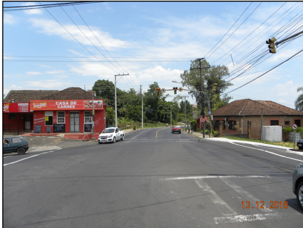
FOTO XI: Vista para a pista em direção à Rua Guia Lopes. Interseção semaforizada, possui faixas de retenção de tráfego e para pedestres (deficientes).
