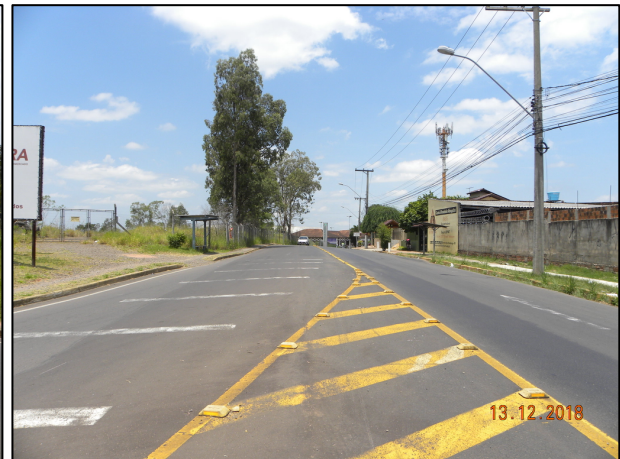
FOTO VII: Vista para a pista em direção à Prefeitura Municipal de Novo Hamburgo. Área com restrição parcial de estacionamento junto à rotatória. Separação das pistas com tachões e faixa contínua simples (proibição de ultrapassagem)
