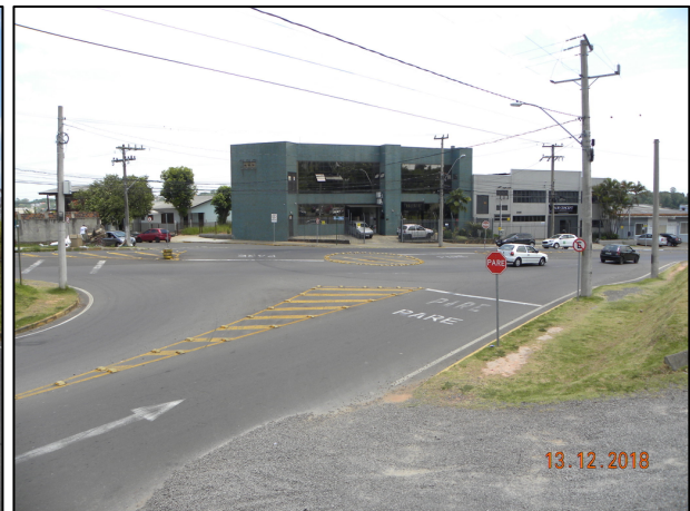
FOTO IX: Vista para a pista em direção à rua Maria Olinda Teles. Pista dividida por faixa simples com tachões e faixa de canalização para ingresso na rotatória. Proibição parcial de estacionamento em ambas as pistas.
