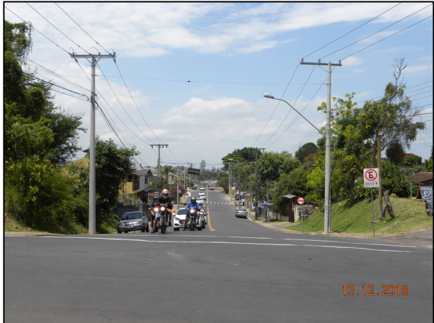
FOTO XI: Vista para a pista em direção à Rua Guia Lopes. Interseção semaforizada, possui faixas de retenção de tráfego e para pedestres (deficientes).
