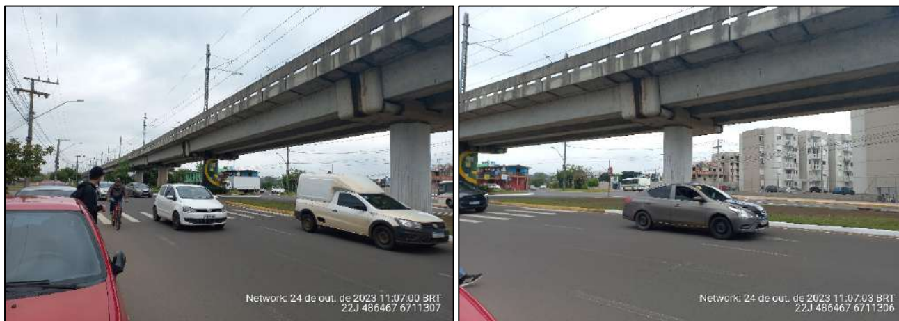
FOTO 3 e FOTO 4: Vista, de oeste a leste, da via Av. Primeiro de Março próximo à faixa de pedestres localizada próximo à Rua Dr. Simões Lopes.
